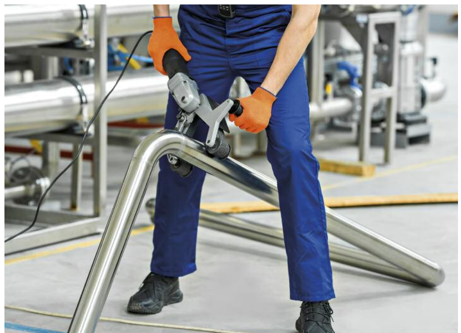
Händisches Schleifen von nichtrostendem Stahlrohr zur Angleichung der Schweißnaht an die herstellereitige Oberfläche © Olya Humeniuk/Shutterstock.com
