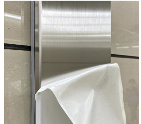
Eine abziehbare Folie schützt die Oberfläche des nichtrostenden Stahls während der Verarbeitung und des Transports vor Kratzern und Schmutz. © IMO A
