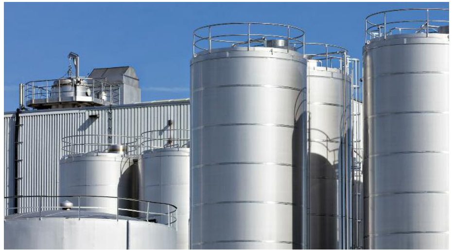
Geschweißte Lagertanks einer Molkerei © iStock.com/Bim
