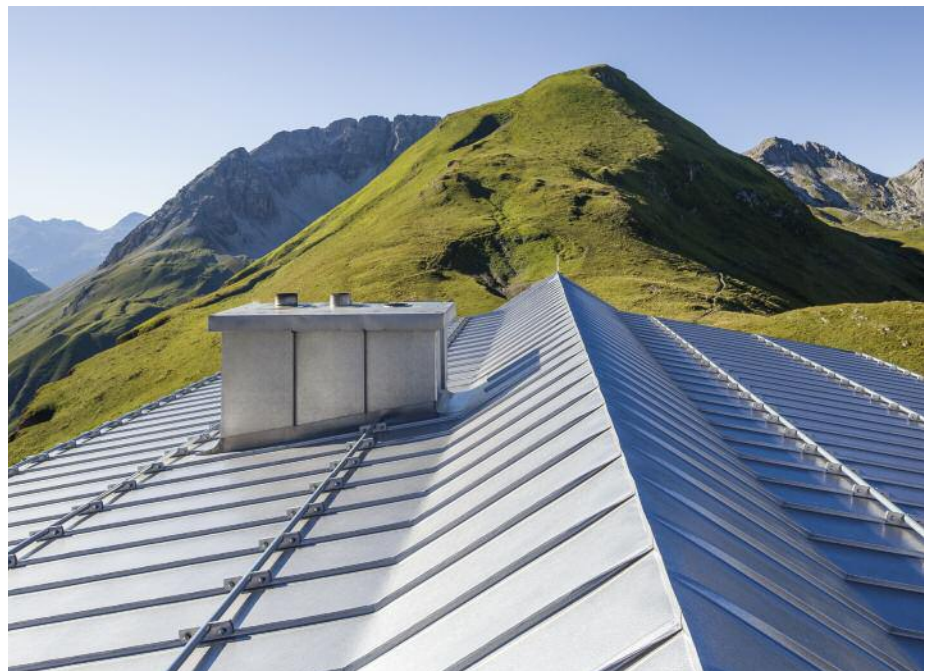
Die Doppelfalze dieser Stehfalzbedachung ergeben auch unter den harschen Bedingungen im Hochgebirge – hohe Windgeschwindigkeiten, hohe Schneelasten und extreme Temperaturen – eine dauerhaft dichte Verbindung. © Roofinox
